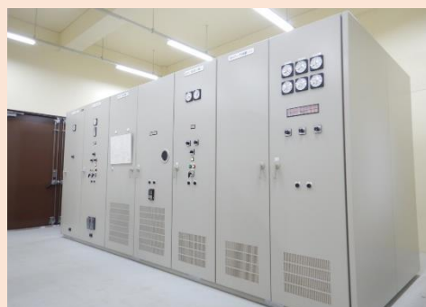
妙見浄水場送水ポンプ電気設備更新工事 (送水ポンプ引込盤、監視設備機能増設ほか)
