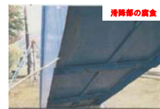
滑降部の腐食
