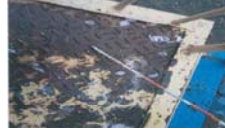
滑降部の腐食
