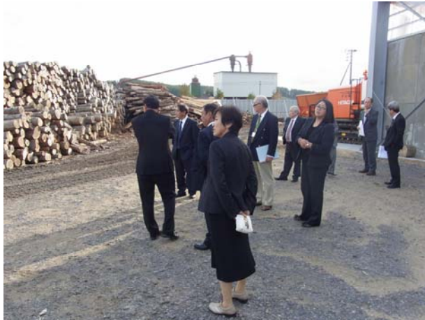
下川町木質原料製造施設
