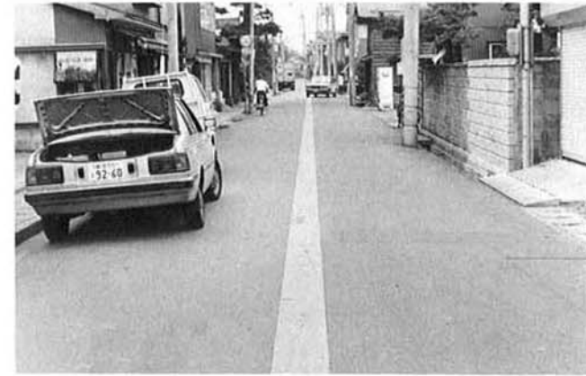
▼ 威力を発揮した長町の消雪パイプ
