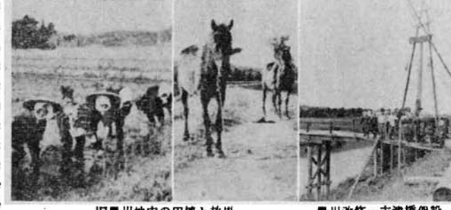
旧黒川地内の田圃と放馬 黒川改修・吉津橋架設
