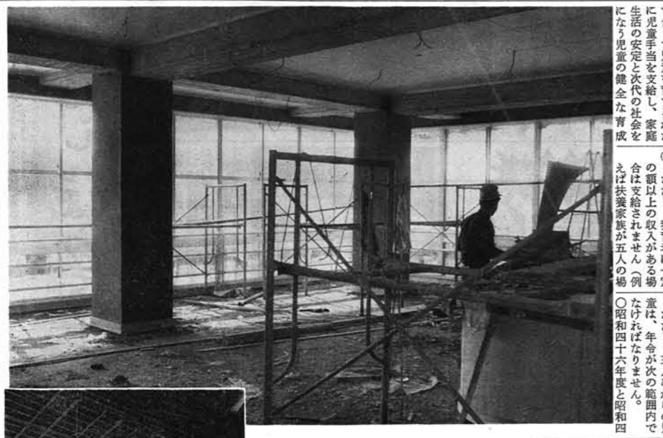
建設中の学校
