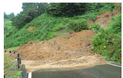
土砂崩れにより通行不能になった県道(虫亀)
