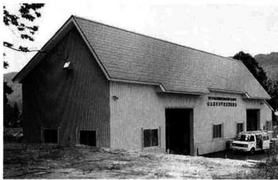
完成した共同乾燥調製施設
