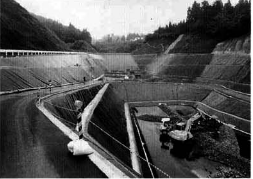
完成に向けて工事が急ピッチに進む
