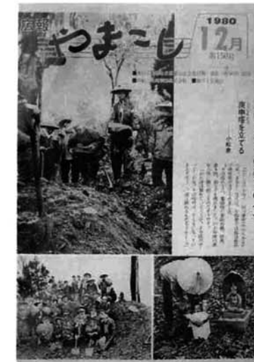
〈第150号 昭55・12・1〉 村の人口は3,508人 (国勢調査概数) 順調に進んでいます 竹沢小学校舎新築工事
