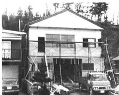
建設中の駅前公会堂
