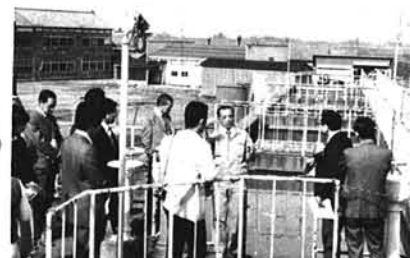
水道企業団浄水場
