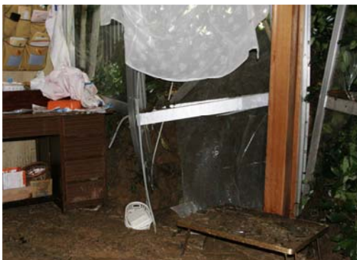
▲住宅に押し寄せた土砂(城之丘)
