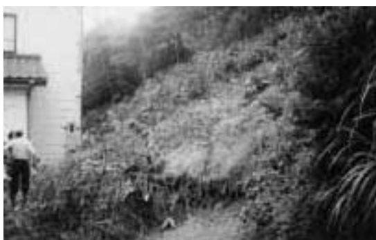
文化スポーツセンター 裏山地すべり 7月15日
