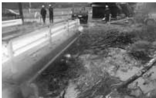
小島谷 ワタチ堤前の橋 7月13日
