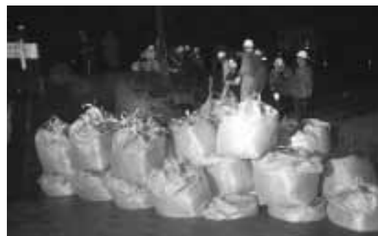
ワタチ堤前の橋 堤防を補強 7月17日
