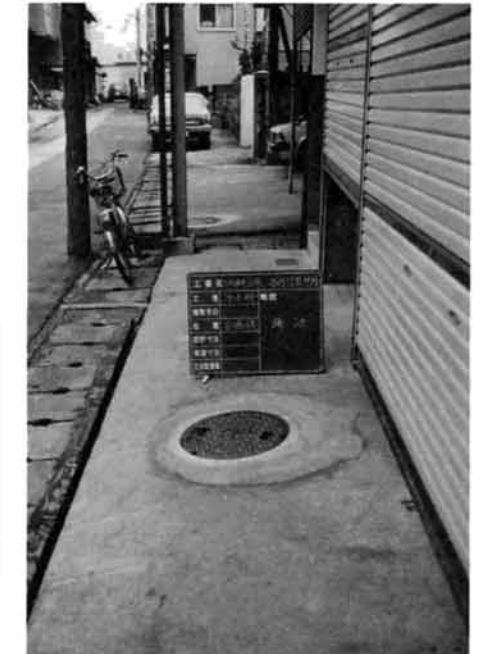
設置された汚水ます
