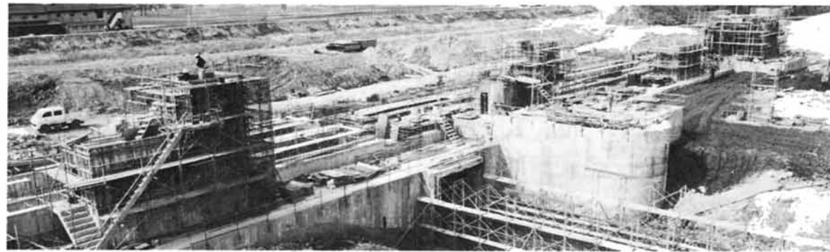
建設中の終末処理場 水処理槽
