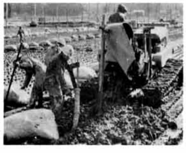
初冬の日差しを受けて暗渠工事(下塩谷)
