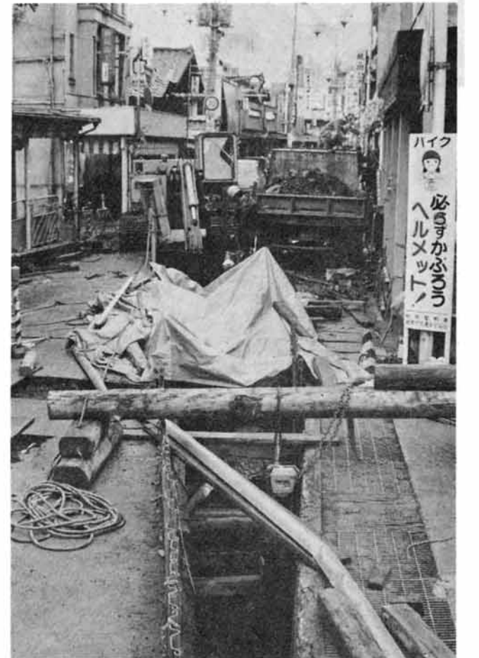
谷内1(国道290号)も幹線管埋設で掘り起し
