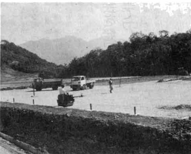
道院の池手前に建設中の運動広場。9,400平方メートルに野球場、バレーボールコート1面、テニスコート2面をつくり、道院を訪ずれた人が十分運動を楽しめるようにする。
