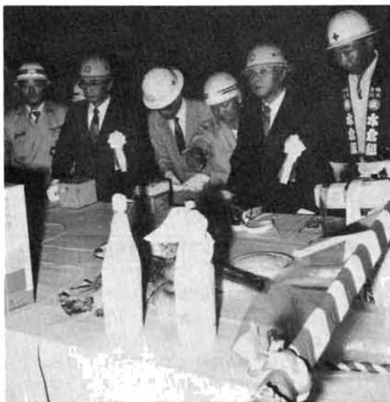
【写真上】トンネル300メートルの地点。ここまでコンクリートが巻かれていた。9月20日。 【写真下】貫通式で最後の発破のスイッチを入れる市長など。
