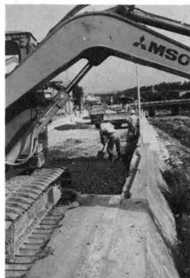
歩道の区画もでき、舗装の基礎工事が進められていた(6月30日)
