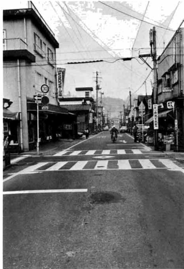
金町2丁目に枝線管埋設
