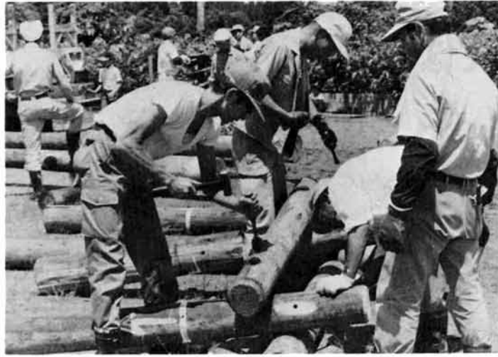
父兄の中には、大工さんがいて、家を造るような熱の入れよう。古電柱をきれいに切り込み、ポートで締められる。
