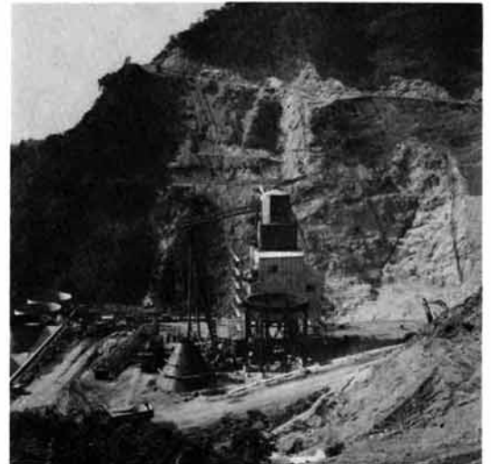
コンクリート製造施設
