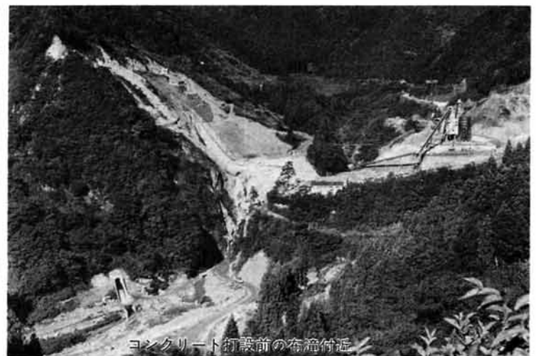
コンクリート打設前の布籠付添
