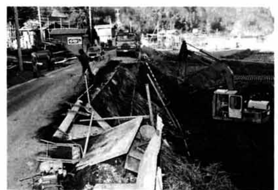
昨年の6・26災害で痛めつけられた河川や道路の復旧工事が、市内のいたる所で行われています。本格的な降雪期を迎え、一刻も早く完成するよう頑張っています。
