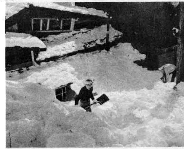
狂ったように降る雪で、何回となく雪を下ろし、ついに屋根の方が低くなった (表町 2月4日)
