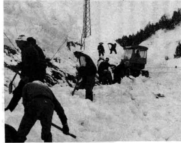
村の幹線道路に雪崩の危険が！ 部落民が総出で除雪作業 (半蔵金部落 2月5日)
