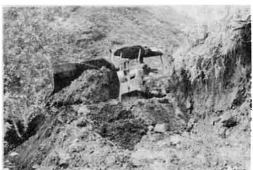
林産物の生産をあげるために林道開設に力を入れます（林道不動線（入塩川））
