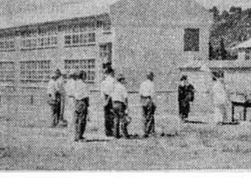
【栃尾中学校での地鎮祭】
