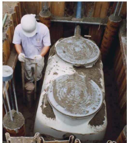
下水道区域外での生活環境向上と 水質保全のため、合併浄化槽の設 置に補助しています
