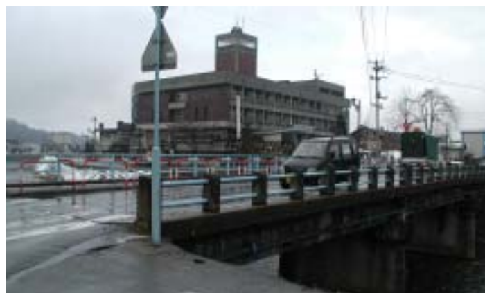
今年度から架け替え工事に着手する市役所前の新金橋。住民に最も身近な歩道などの整備を進めます。
