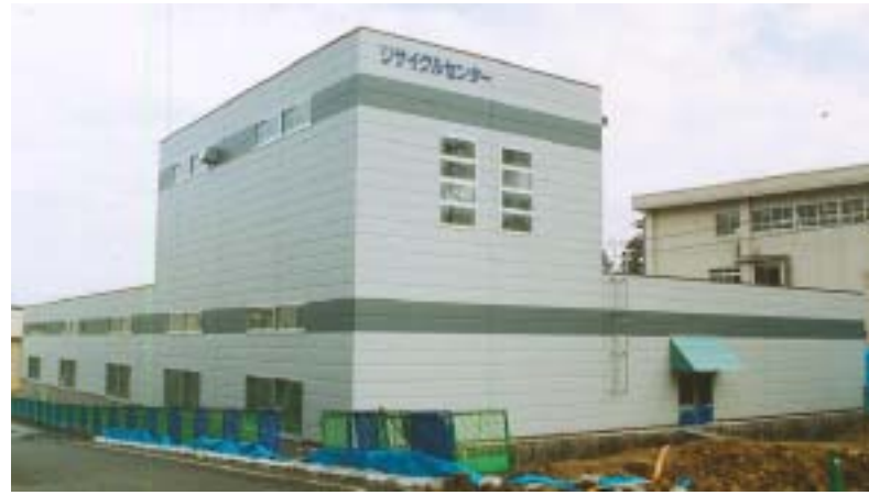
着々と工事が進みリサイクルセンター。4月からリサイクル品目が増え、ごみ半減に向けた取り組みが一段と強化されます。分別収集にご協力ください
