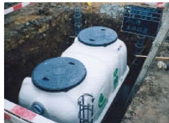
公共下水道計画外地域には、昨年に続き合併処理浄化槽の設置補助を行います
