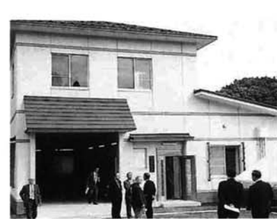
完成した塩谷浄化センター(人面地内)
