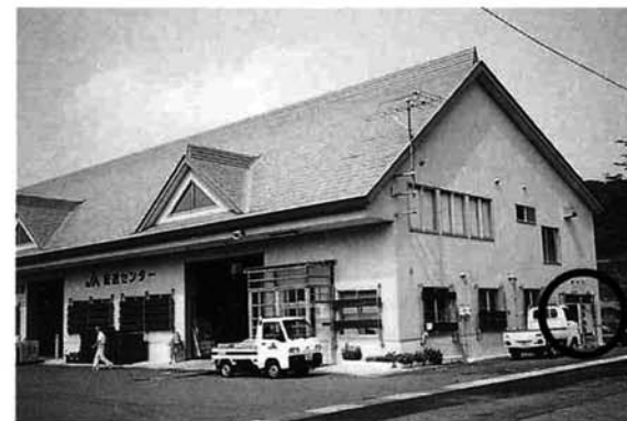
泉地内にある配送センターとガス冷暖房の室外機(右)
