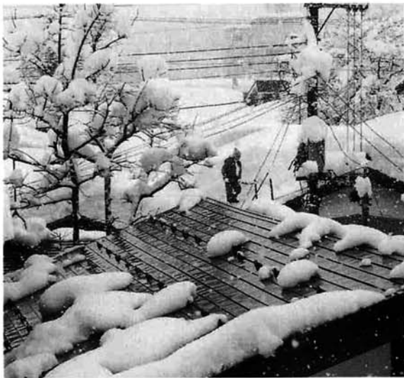
市の補助金を活用した融雪屋根。家並みがこみあった市街地では、雪下ろしのスペースが少ないため、融雪式が多い
