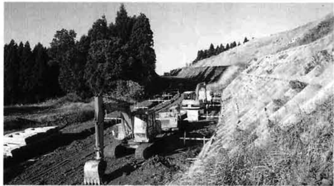
平地内に建設中の国道290号バイパス。写真は宮沢橋から平・東が丘方面に向かってのもの。宮沢から大野町への工事も同時施工中
