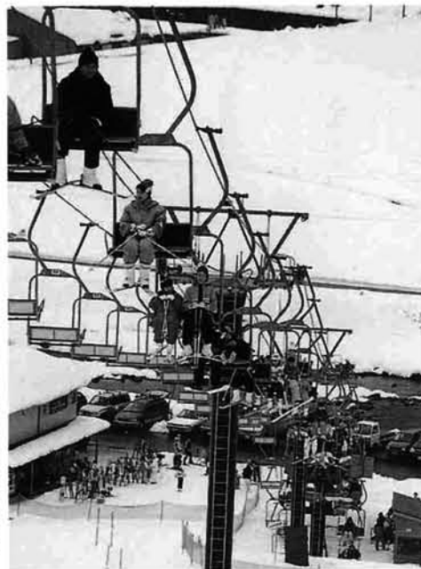
▶リフトや管理塔の整備により、土・日には市外からもスキーヤーが訪れる「とちおファミリースキー場」
