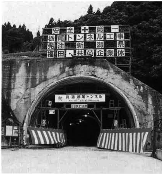
昨年7月に貫通し、平成13年の共用をめざす栃尾トンネル。環状道路の役割も兼ねており、市内の渋滞緩和が見込まれます(栄町地内)
