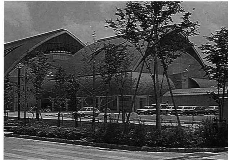
長岡市にある長岡市市民体育館
