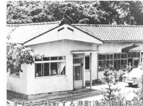
まもなく移転する港町浄水場事務所
