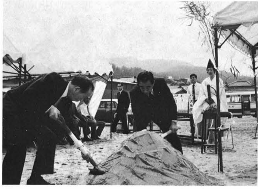
▲起工式で工事の無事完成を願って力強く鉄入れをする中島町長
