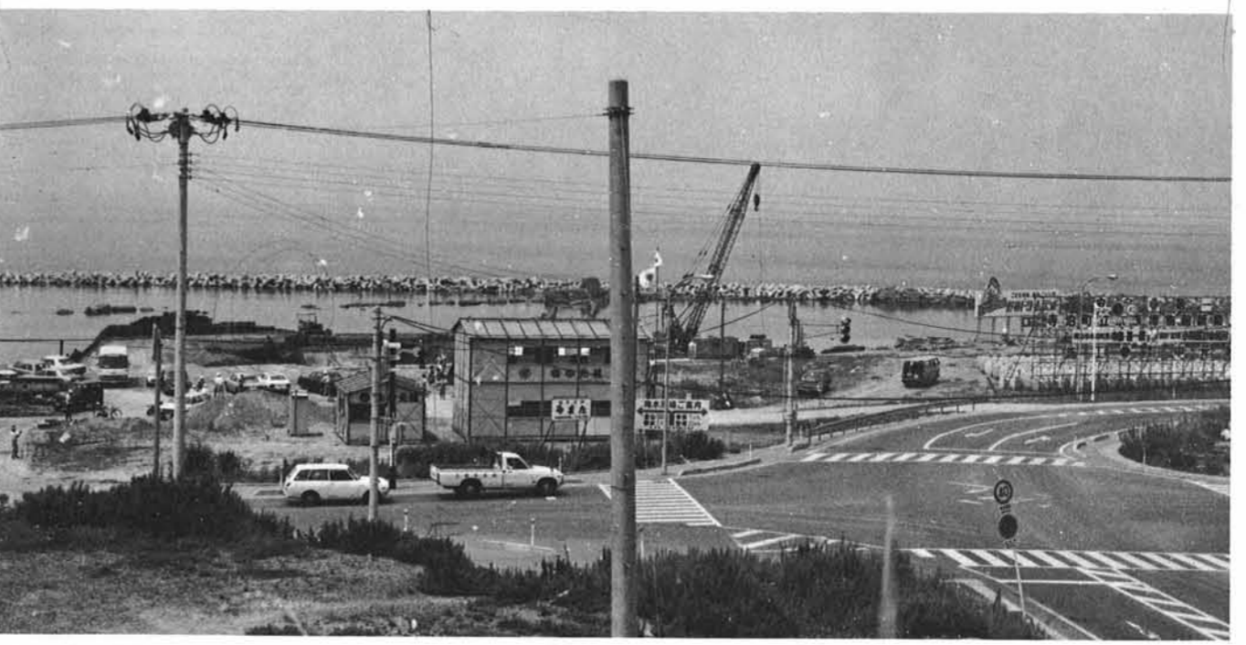
▲観光のメインとなる水族博物館建設基礎工事が急ピッチ
