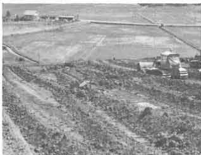
大河津小学校建設用地
