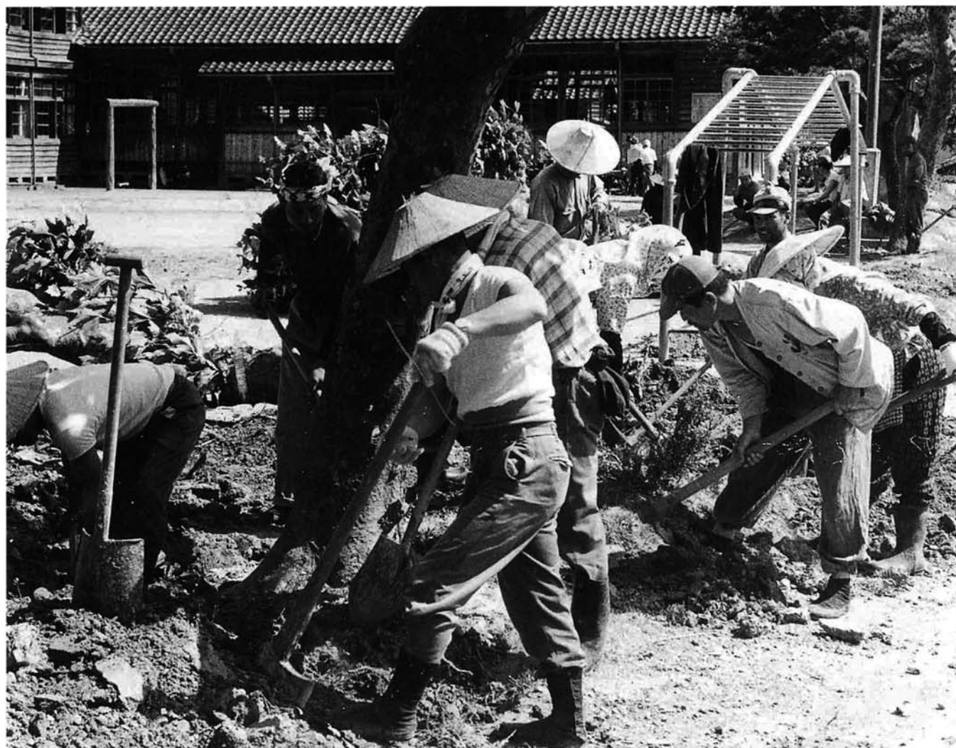
現在のひかり保育所のところにあった夏戸小学校の旧木造校舎。 昭和42年5月、グラウンド拡張工事に協力し、汗を流すPTAや地域のみなさん。 (写真提供 夏戸小越平之丞氏 資料提供 夏戸小学校)
