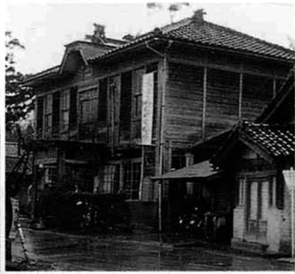
↑竣工後の庁舎
