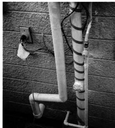
保温ヒーター取付
