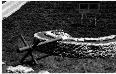
完成した「月の輪工法」
