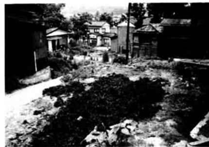
改良工事により生活道路の整備が進む
