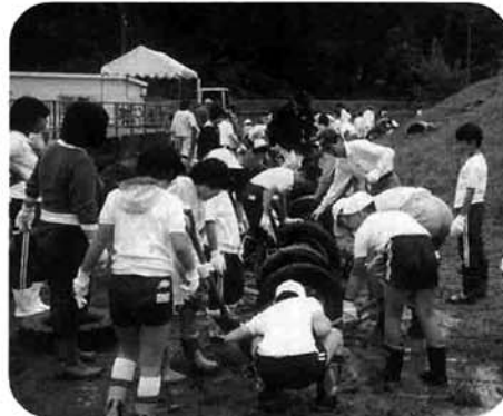
タイヤ遊具の設置
