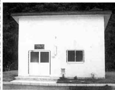
昨年完成した「八王子地区 営農飲雑用水浄水場」
