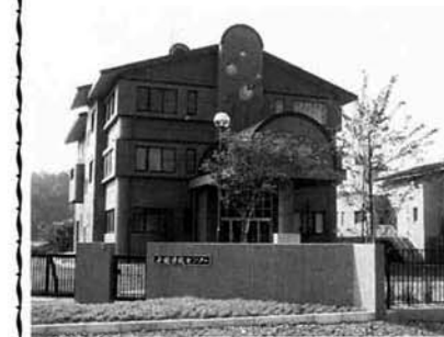
昨年完成した「小国浄化センター」
