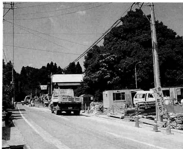
▲苔野島地内ですすめられる管路工事
