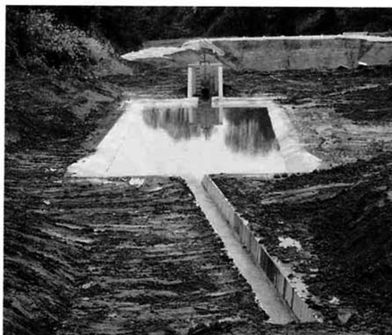
▲ 工事の進む沈澱調整池
