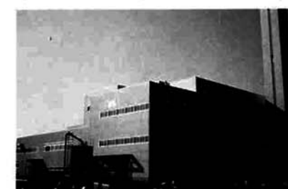
▲完成間近な新ごみ処理施設
