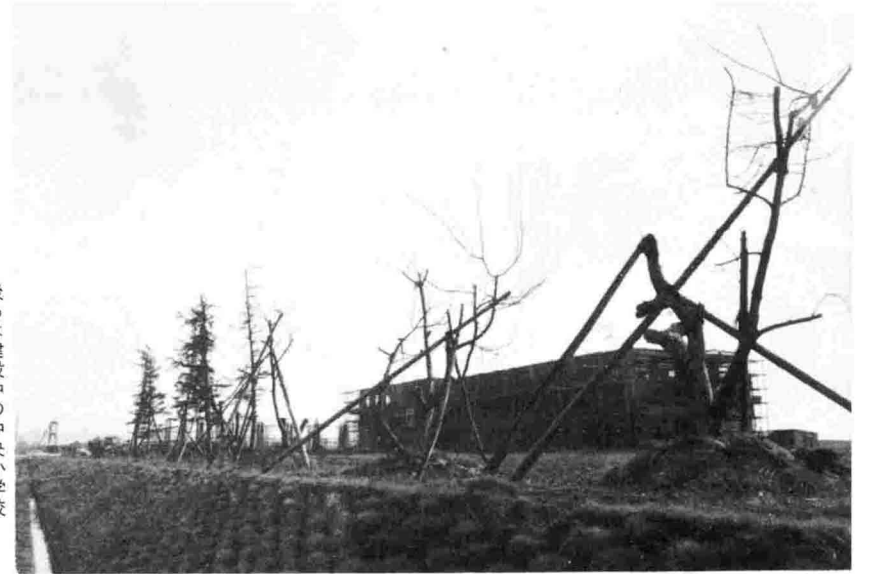
後ろは建設中の中央小学校
