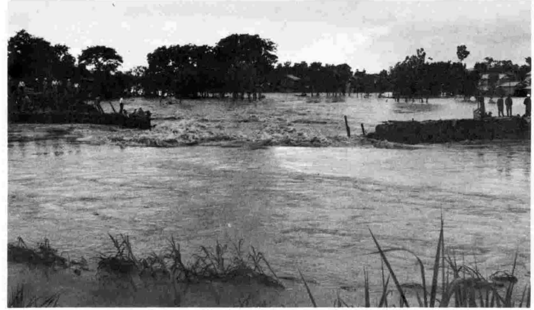
昭和39年7月7日午後八時。ついに増水に耐えられず決壊した堤防
