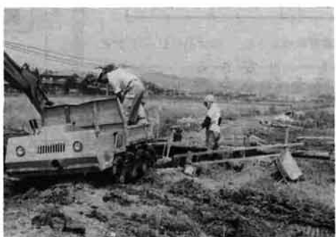
進む「ほ場整備事業」(新保地内)
