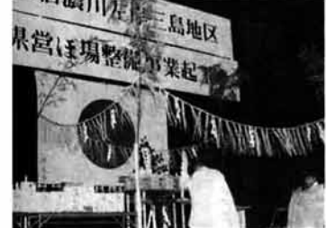
工事の安全と成功を祈願する神事
